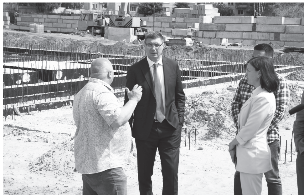
А. Авдеев и глава г. Коврова Е. Фомина на строительной площадке школы в мкр. Салтаниха.
