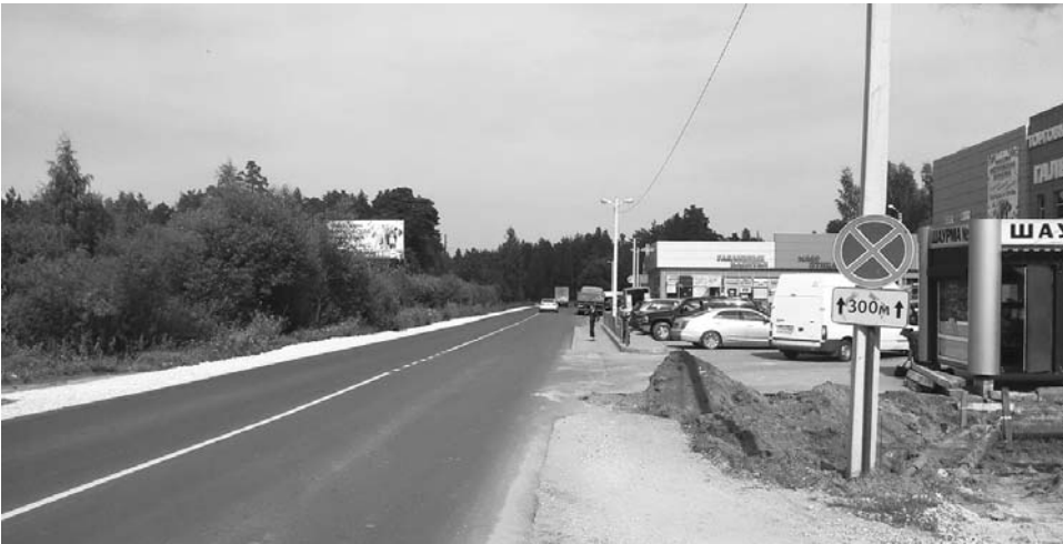
Дорога по улице Ленинградской после ремонта.
