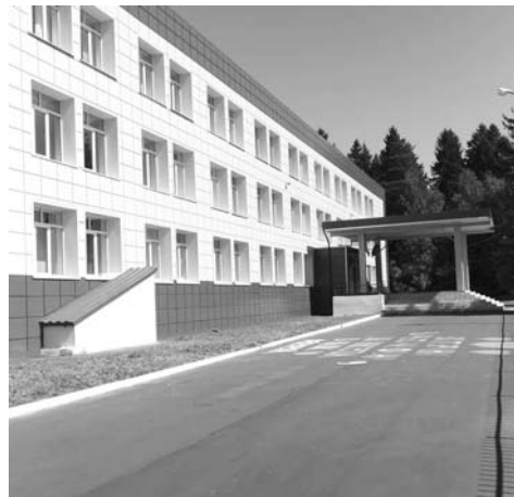
Фасад средней школы № 7 после ремонта.
